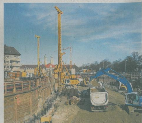
Die Tunnelbaustelle am Luise-Kiesselbachplatz ist hochkompliziert. Bis 2015 soll der Tunnel dennoch fertig sein.
