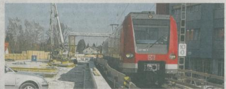
Vor dem Tunnel: Die S8 in Unterführung – noch oberirdisch.
